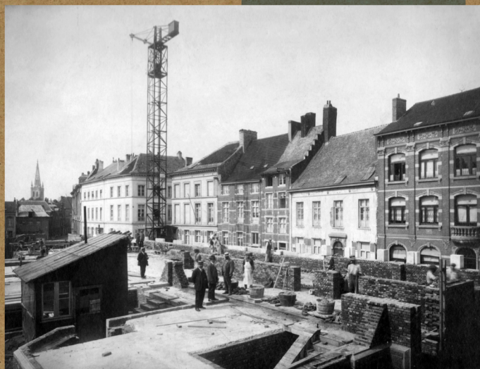
Foto van de ruwbouw van het Leuvens gerechtsgebouw, 1923. Fotograaf Richard Morren staat met zijn rug naar de Diestsestraat. Achter de kraan ligt het kruispunt Vaartstraat-Rijschoolstraat. Collectie Leuven Weleer - André Crèvecoeur.
